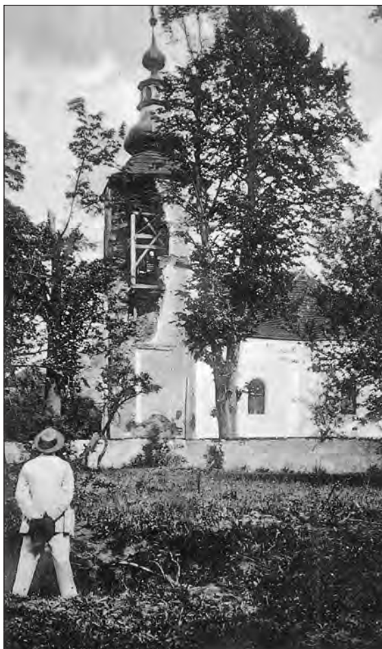
Poškodený gréckokatolícky kostol v obci Stebník ( www.kvhbeskydy.sk )
