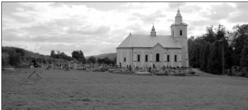
Vojenský cintorín v Čabinách v čase rekonštrukcie
