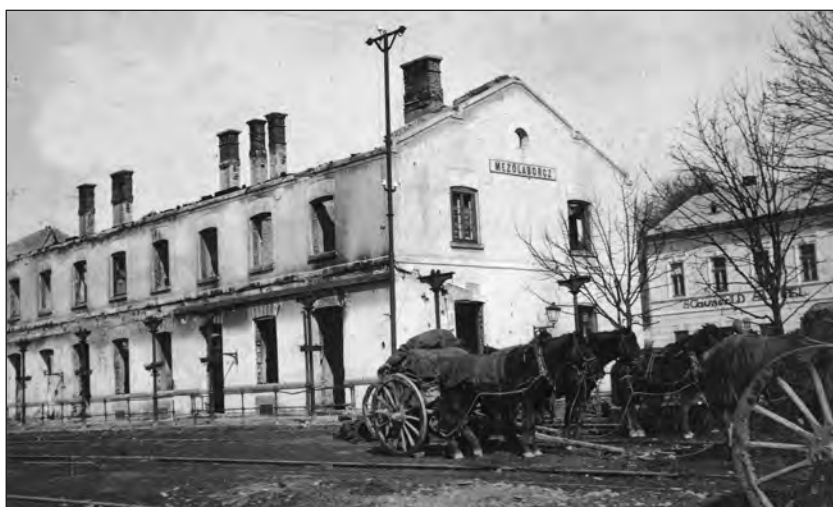
Zničená budova železničnej stanice v Medzilaborciach. Znisčený budynek dworca kolejowego w Medzilaborcach.
