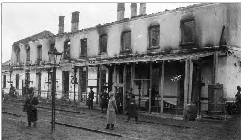
Zničená budova železničnej stanice v Medzilaborciach. Znisčený budynek dworca kolejowego w Medzilaborcach.
