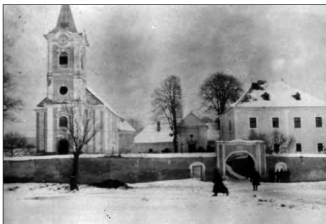
Kláštor v Krásnom Brode pred poškodením delostreleckou paľbou. Klasztor w Krásnym Brodzie przed zniszczeniem przez ostrzał artyleryjski.
