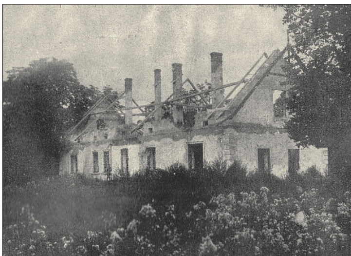
Zničené dom v obci Sękowa Zniszczony dom we wsi Sękowa
