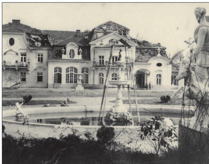
Poškodený kaštieľ Długoszovcov Uszkodzony pałac Długoszków
