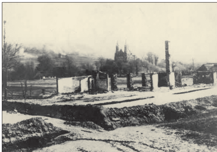
Zničené budovy v Sękowej Zniszczone budynki we wsi Sękowa
